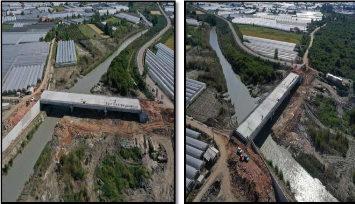
Foto-3: Arazi Çalışmalarından Genel Görünüm
