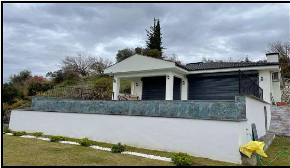
Foto-5: Yapı Kullanma Belgesi Düzenlenmiş Yapı
