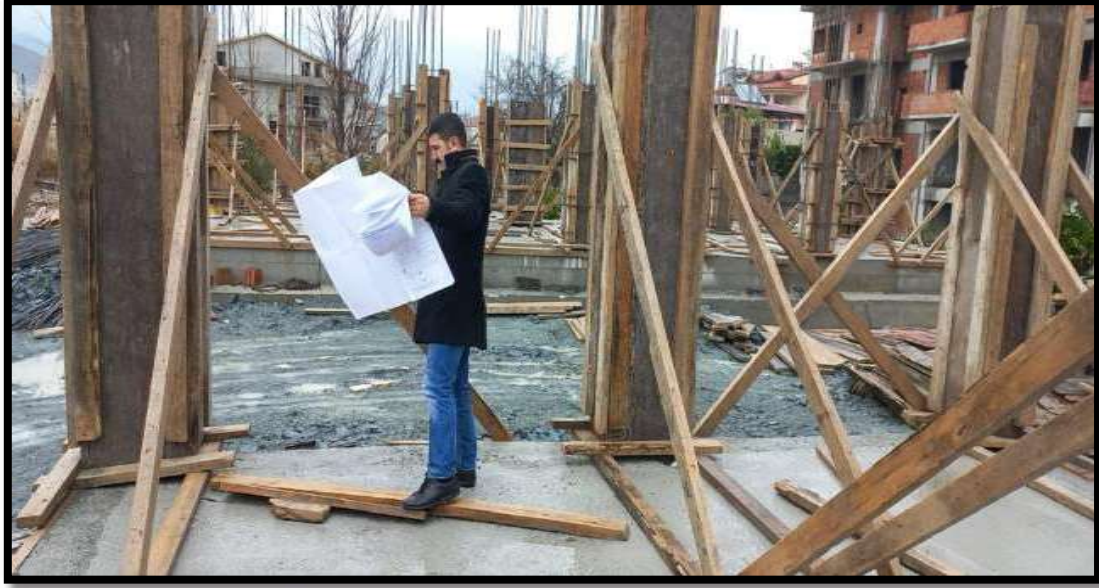
Foto-4: Proje Kontrollerinden Bir Görünüm
