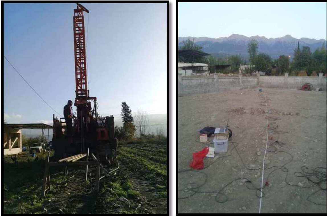
Foto-7: Zemin Etüt Çalışmalarından Bir Görünüm
